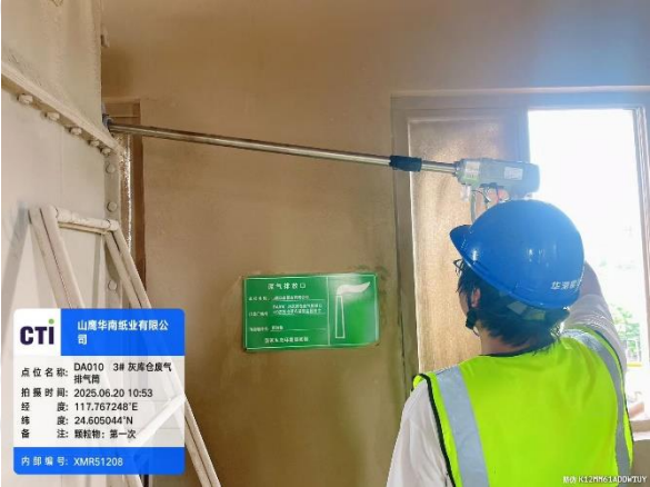
DA010 3#灰库仓废气排气筒
