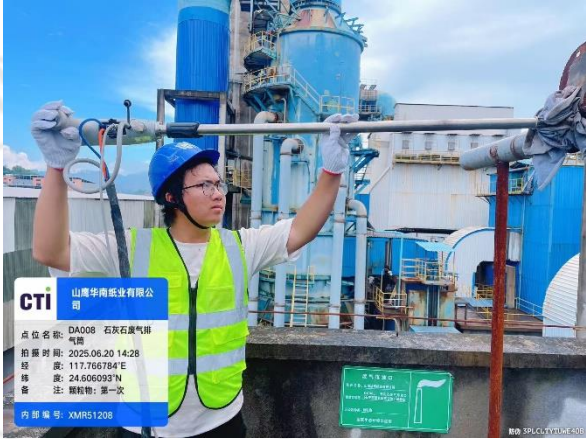
DA008 石灰石废气排气筒
